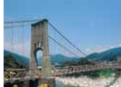
桃介橋 福沢桃介が水力発電開発のために木曾川に架けた吊橋で、全長247m、日本でも最大級の木橋です。近代化遺産として国の重要文化財に指定。
